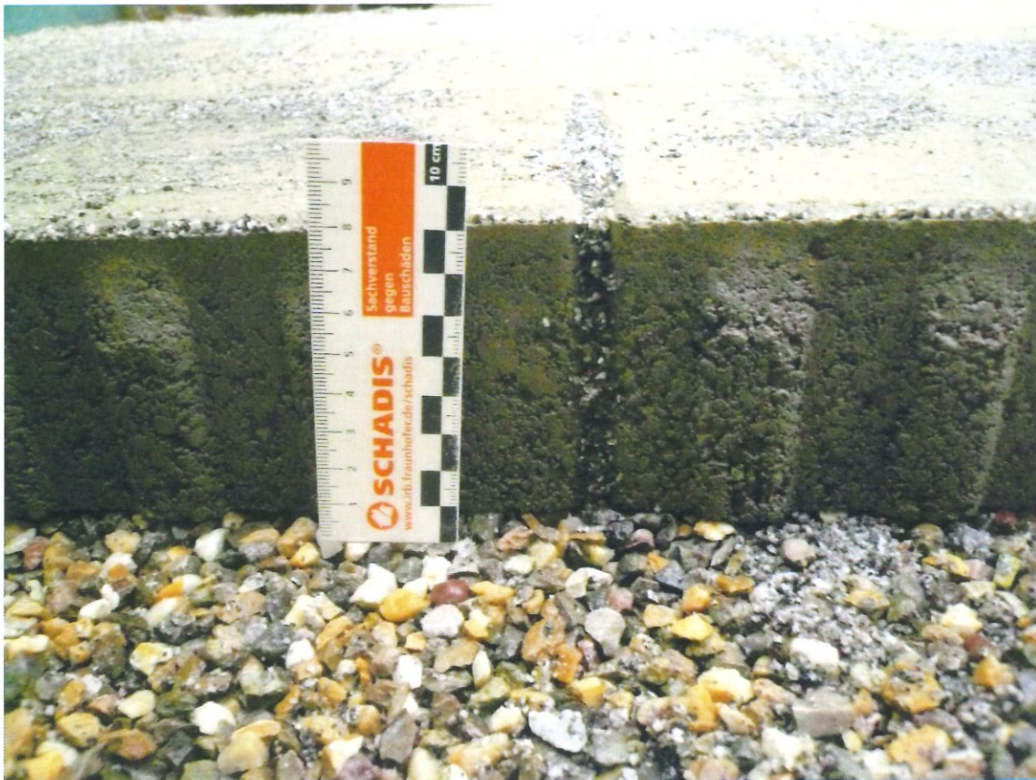
Bild 5: Detailansicht, Fuge nach Bewässerung
