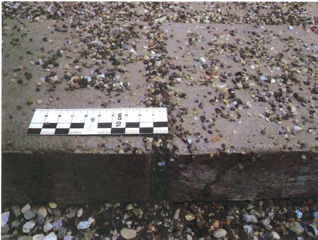
Bild 7: Detailansicht, Fuge nach Bewässerung
