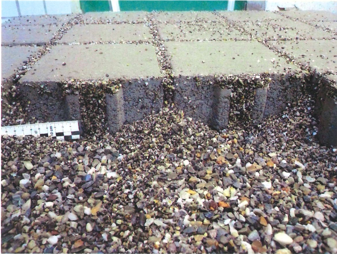
Bild 6: Detailansicht, Fuge nach Bewässerung
